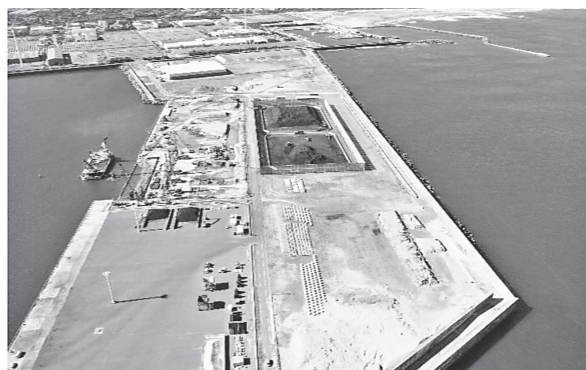
基地港湾として整備中の鹿島港外港公共埠頭
