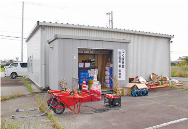
常総広域消防本部つくばみらい市消防署谷和原出張所敷地内(第二格納庫)
