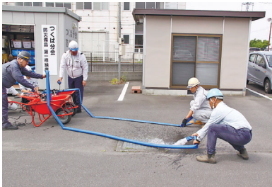
つくばみらい市役所敷地内(第一格納庫)
