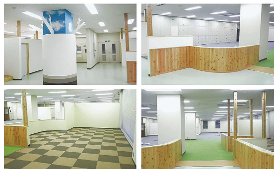
常陸太田市分庁舎1階内部改修工事(子育て世代包括支援センター)
