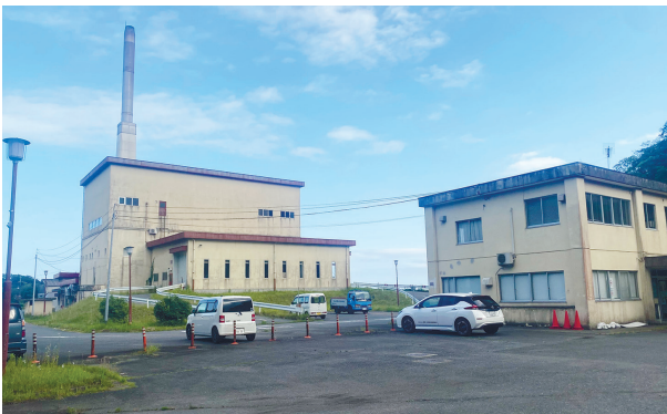
解体する旧北茨城市清掃センター
