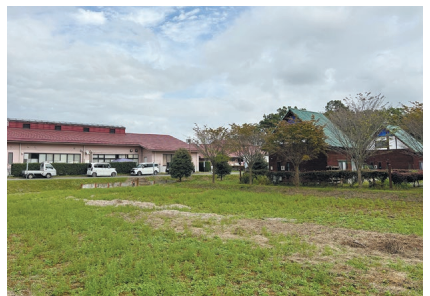
改修を進めるグリーンビレッジ
