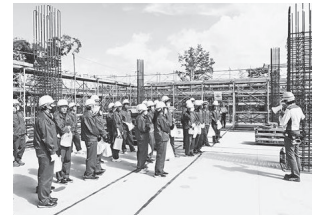
現場見学会で学生に建設の魅力を伝えています
