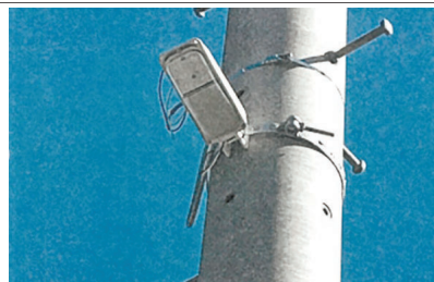
令和5年度第1号防犯灯新設工事
