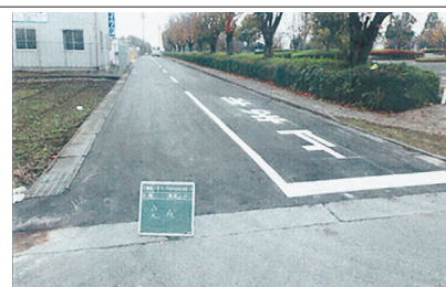
R5第2号上平塚地内道路改良舗装工事
