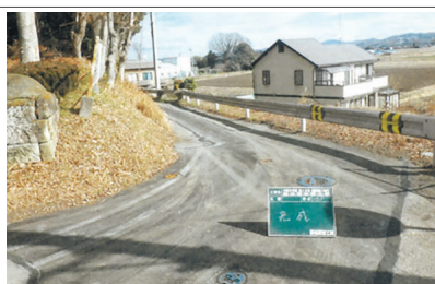
第15号創設樋口地内配水管布設工事
