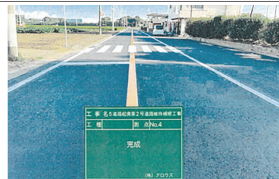
5道路起備第2号道路維持修繕工事
