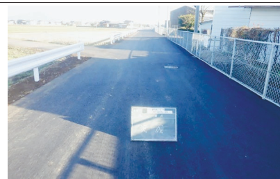
R5国補狭あい第1号伊讃美地内道路改良舗装工事
