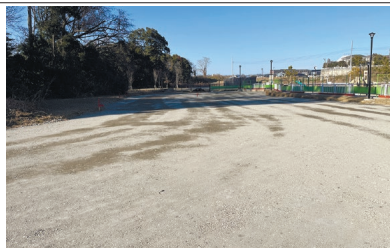
第06-22-212-K-101号 神楽沢近隣公園駐車場造成工事
