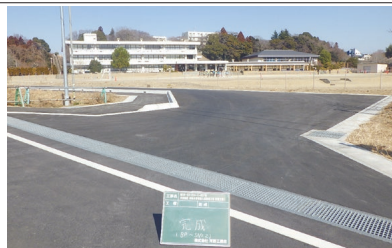
第06-23-204-K-801号 中央地区村松小学校進入路整備工事(2期工事)
