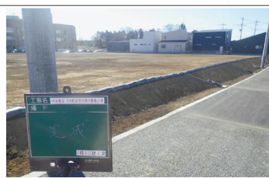
第06-23-1204-K-1804号 中央地区54街区符号1-1ほか整地工事
