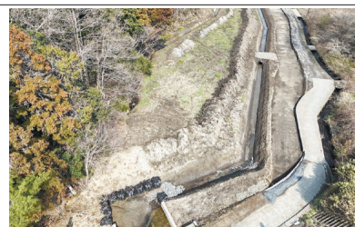
第06-32-207-K-1001号 絆北側2号調整池粗造成工事
