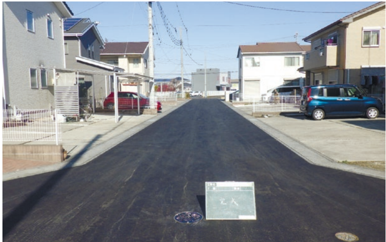
R 5 線国交公下第3号・R 6 国交公下第1号・R 6 町単公下第3号 第1 処理分区分枝線整備工事
