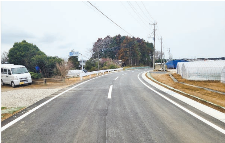
R 6再編関連道路改第2号 道路改良工事
