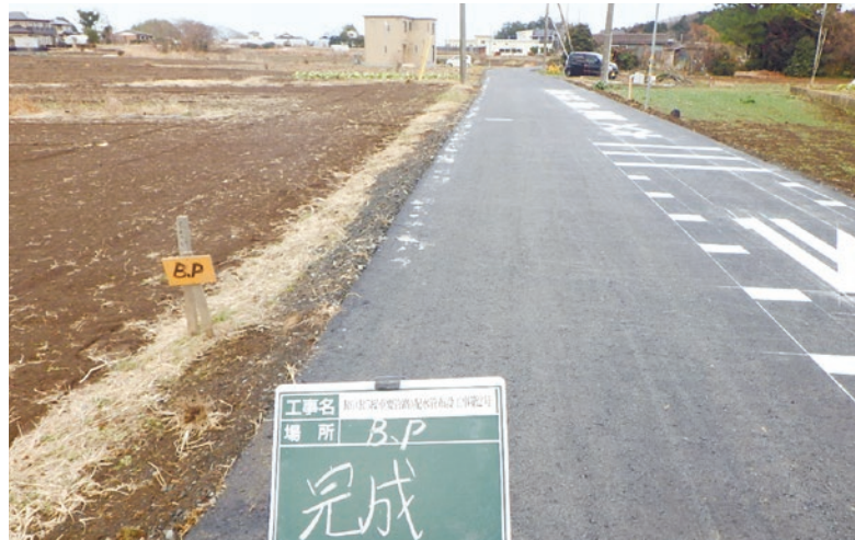
R 6 (R 5 線重要管路) 配水管布設工事 第2号
