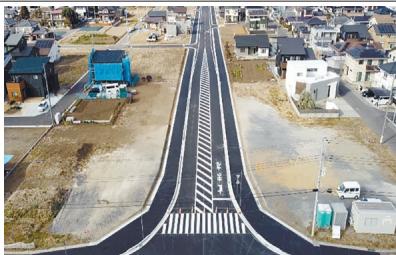
(24年度 完成工事3件) 中根六ツ野線道路改良工事 (R6都再六区第1号)
