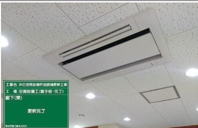
(24年度 完成工事3件) 休日夜間診療所空調機更新工事
