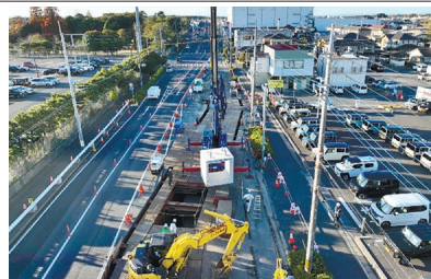
(24年度 完成工事11件) 高場雨水4号幹線管きよ布設工事 (R5国補公下第1号)
