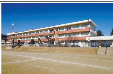
R6 園部小学校外部改修工事
