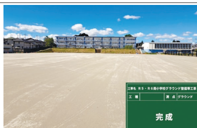
R5 R6南小学校グラウンド整備等 工事
