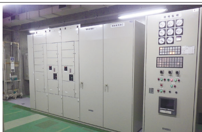
R5 国補石岡第2中継ポンプ場 ストックマネジメント設備改築工事
