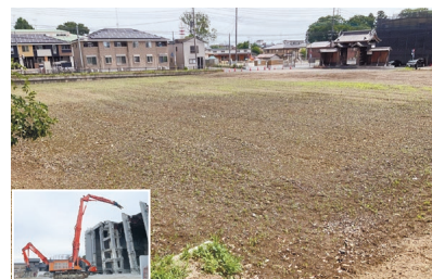
令和5年度 市民会館解体工事
