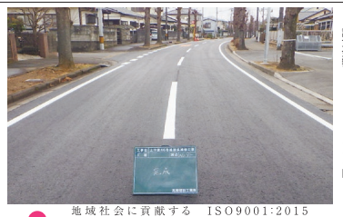
国保流通関連下水道通川第3処理分区分区1-1工区工事(住吉町)
