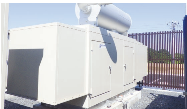
新斎場建設電気設備工事(入野町)
