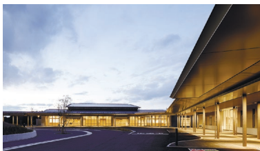
新斎場建設電気設備工事(入野町)
