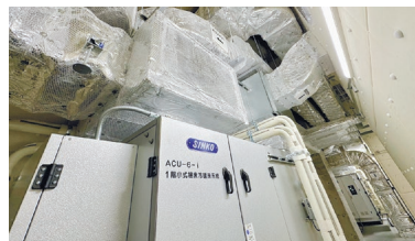
新斎場建設電気設備工事(入野町)
