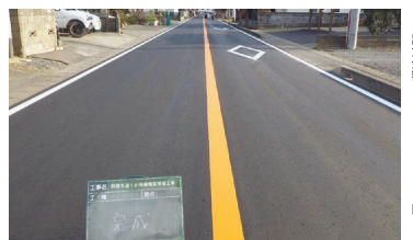
国保流通関連下水道通川第3処理分区分区1-1工区工事(住吉町)
