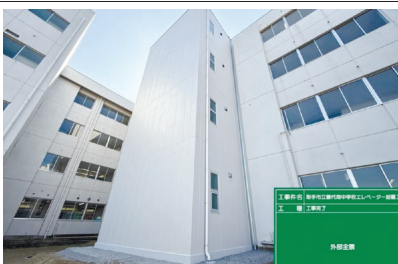
【建築部門】 取手市藤代南中学校エレベーター設置工事
