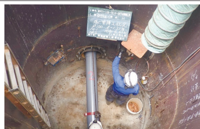
【その他部門】 取手クリーンセンター下水管 接続工事
