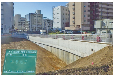
【土木部門】 6社総交差点第1-11号都計道3-5-39号線 道路擁壁工事
