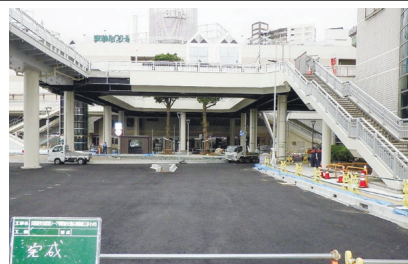
【土木部門】 5社総交差点第1-7号駅前交通広場整備工事 その5
