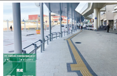
【土木部門】 6社総交差点第1-5号駅前交通広場整備工事 その7
