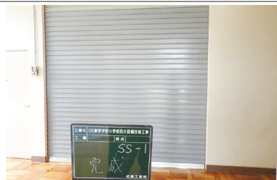
06単学伊奈小学校防火設備改修工事
