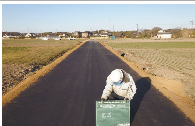
06県建第90号農道舗装工事(福原)
