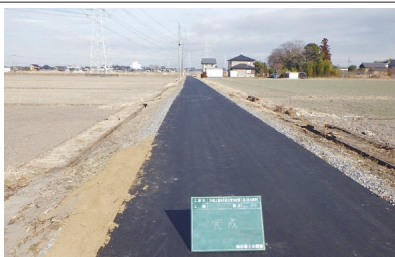
05国上第9号配水管布設替工事(青古新田)
