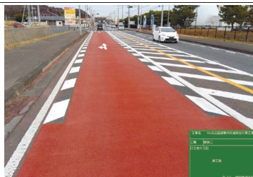
【事務所長表彰】(難工事功労) R6 日立国道管内交通安全対策工事 《常陸河川国道事務所》
