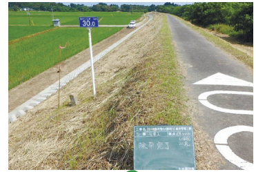
【事務所長表彰】(難工事功労) R5 R6 那珂管内(那珂川)維持管理工事 《常陸河川国道事務所》
