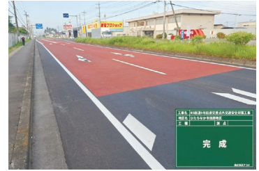
【事務所長表彰】(難工事功労) R5 国道6号田彦交差点外交通安全対策工事 《常陸河川国道事務所》
