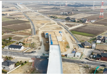
【事務所長表彰】(難工事功労) R5 東関道小泉南地区分交他工事 《常陸河川国道事務所》
