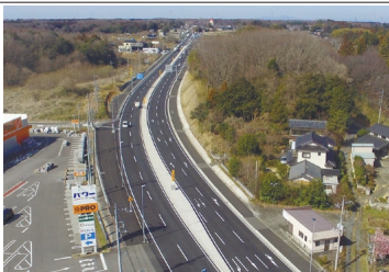
【事務所長表彰】(難工事功労) R6 国道50号桜井西IC関連(延伸)道路照明設置工事 《常陸河川国道事務所》
