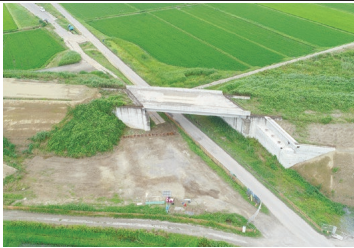
【事務所長表彰】(難工事功労) R5 国道6号代田田辺B.P.幸町・田島下線跨道橋基礎工事 《常陸河川国道事務所》
