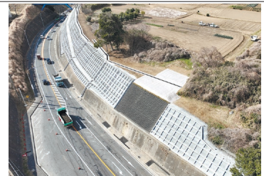
【事務所長表彰】(難工事功労) R5 国道6号日立国道出庫所管内防災他工事 《常陸河川国道事務所》
