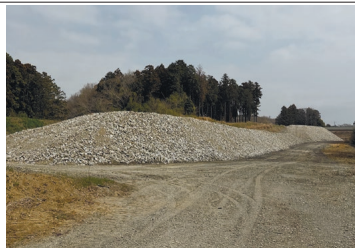
【事務所長表彰】(難工事功労) R5 国道6号代田田辺B.P.東田中地区改良外工事 《常陸河川国道事務所》
