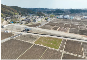
【事務所長表彰】(難工事功労) R5 国道6号勿来田辺B.P.関本町六反田地区改良工事 《常陸河川国道事務所》
