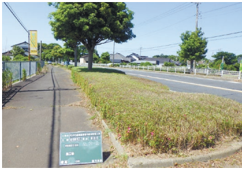
【事務所長表彰】(難工事功労) R5 R6 鹿嶋国道管内緑地管理工事 《常陸河川国道事務所》
