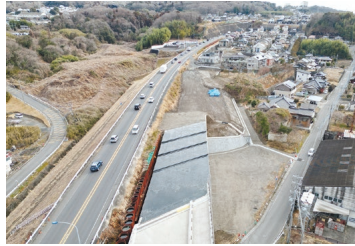
【事務所長表彰】(難工事功労) R5 国道6号大和田田辺分交坂地区改良工事 《常陸河川国道事務所》
