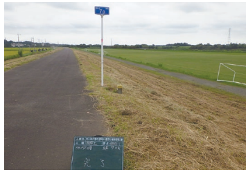
【事務所長表彰】(難工事功労) R5 R6 水台管内(那珂川・酒沼川)維持管理工事 《常陸河川国道事務所》
