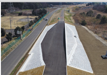
【事務所長表彰】(若手女性技術者奨励賞) R5 那珂川左岸栄町地区外築堤護岸工事 《常陸河川国道事務所》
