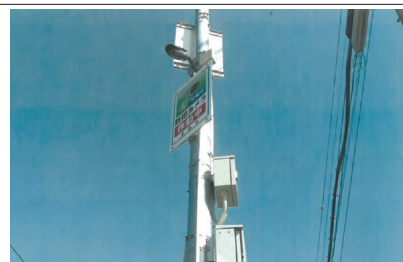
令和7年度防犯カメラ設置工事
