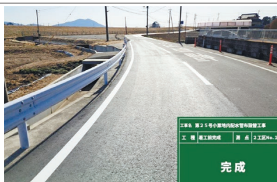
第25号小栗地内配水管布設替工事
