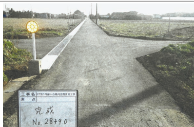
R7第5号藤ヶ谷地内道路改良工事
