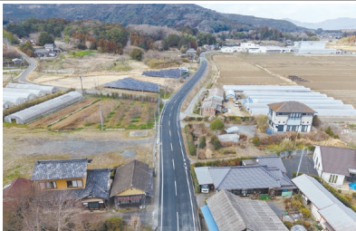
R7 単市道B0107号線 道路舗装工事
