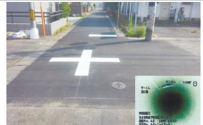
R6 市単公下 管路改築第1号工事
