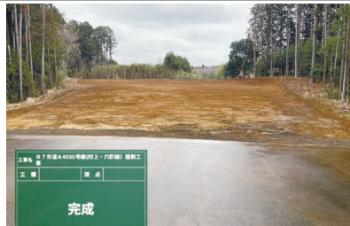
R7 市道A4055号線(村上六軒線) 掘削工事
