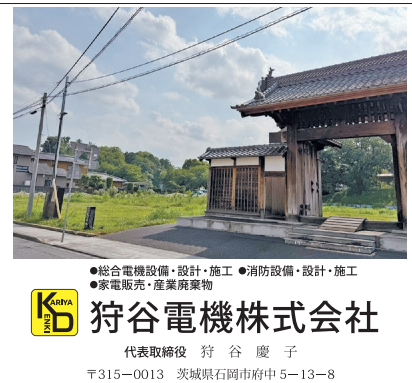
令和7年度 石岡の陣屋門自動火災報知設備設置工事
