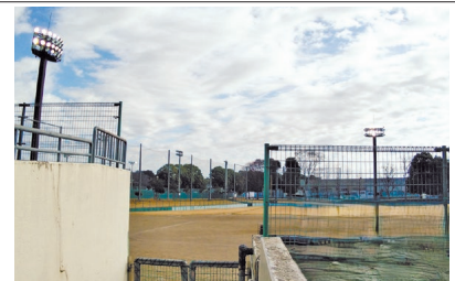
令和7年度 ケーブル交換工事(柏原野球公園)
