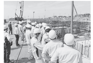
現場見学会を開いて学生に建設業の魅力を伝えています
