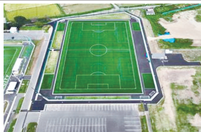
「土木部門」 R06国補前川運動公園多目的広場人工芝工事
