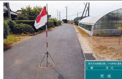
「土木部門」 R06国補流潮下水道地区施設工事
