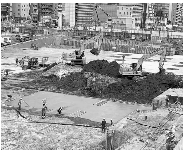
「人力+重機」で作業が進む現在の建設現場
