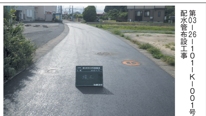
第0312611011K1001号 配水管布設工事 弓山建設工業株式会社 代表取締役 川崎 悟 本社 〒319-1117 茨城県那珂郡東海村東海1丁目1番23号 TEL 029-282-1746 FAX 029-282-3935 日立営業所 〒316-0014 茨城県日立市東金沢町4丁目4番16号 TEL 0294-36-1054 FAX 0294-36-1007
