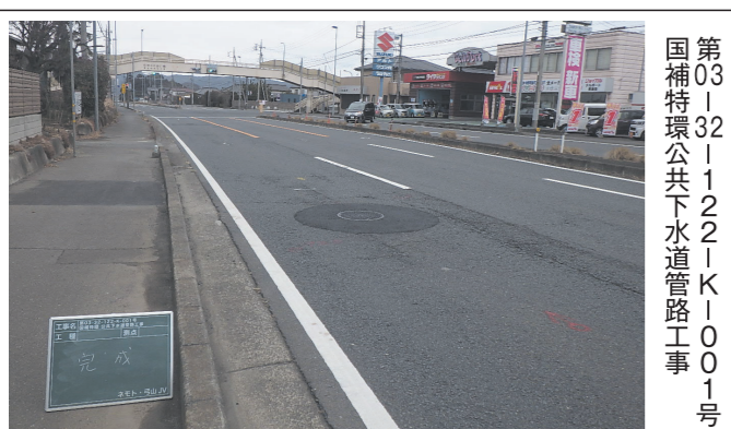
第0313211221K1001号 国補特環公共下水道管路工事 ネモト・弓山 特定建設工事共同企業体
