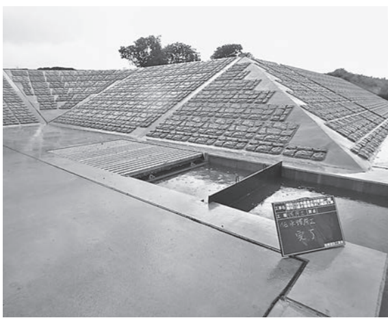
取水口、低水護岸ブロックが完了
