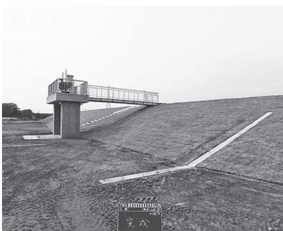
樋門(門柱)、高水護岸を施工した
