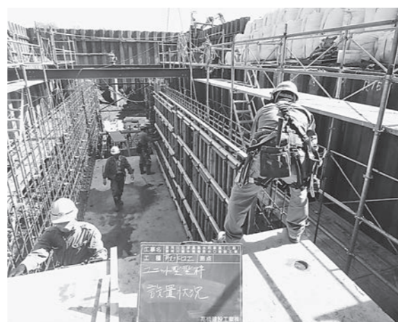
鉄筋や型枠をユニット化し、工期短縮に結び付けた
