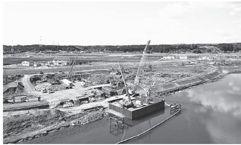
河川を鋼矢板で二重締切し、取水口を建設した
