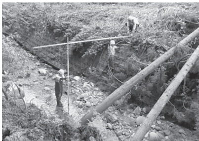
災害現場における現地測量
