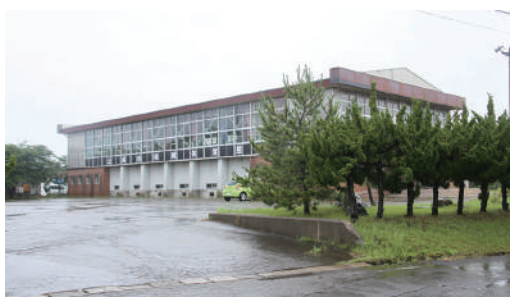
建設候補地の柿崎体育館
