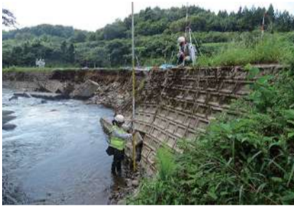
災害現場での測量業務
