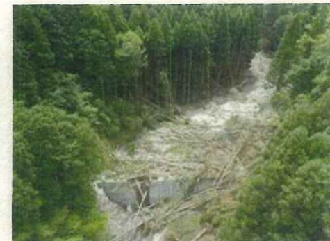
UAVによる砂防ダムの 堆砂状況調査
