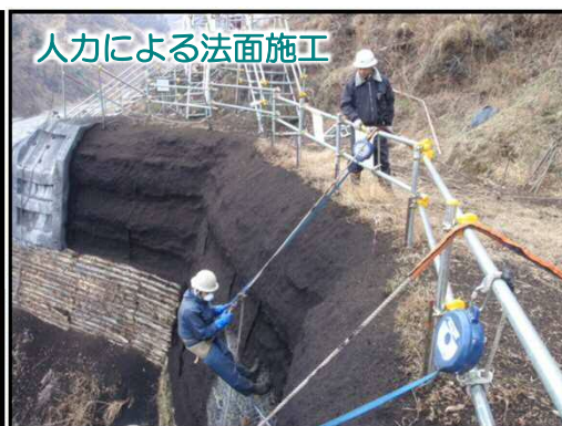
パディ・システムを活用した 安全帯の点検状況
