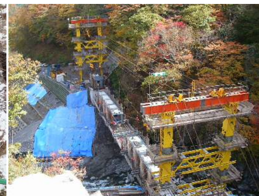
【もうすぐ架設完了】
