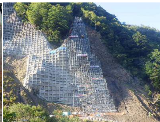
【鉄筋挿入工・仮設足場組立】
