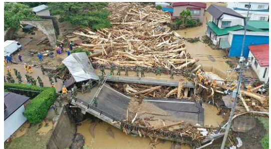
流木による橋梁箇所の閉塞被害 (青森県小赤川)
