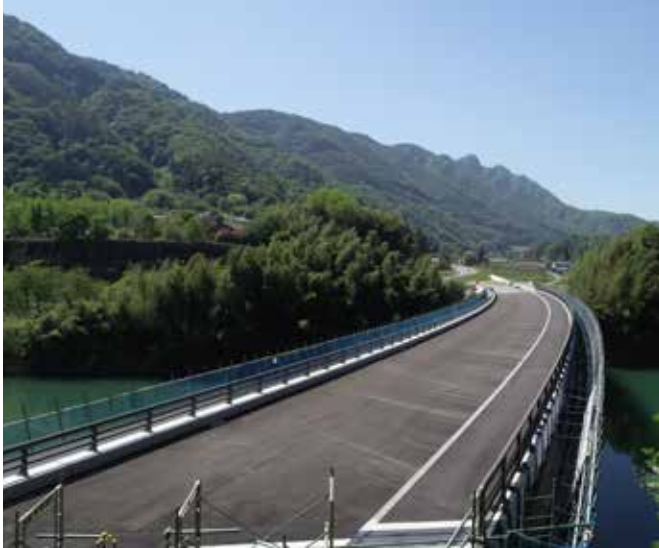
山清路防災1号工事
