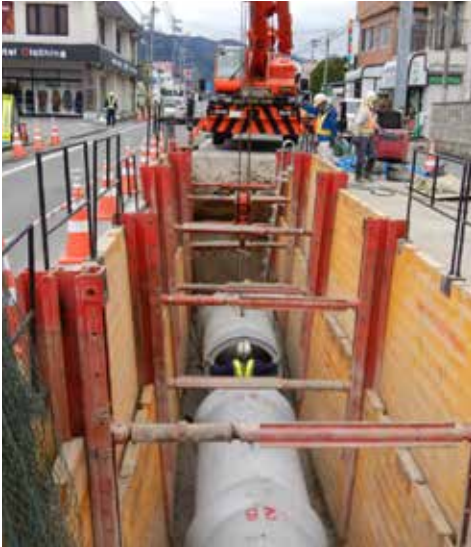
施工中の様子
